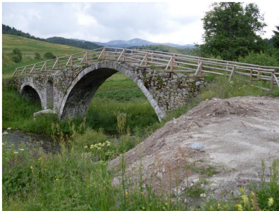
Снимка: Архитектурно-исторически мост „Кемера“
